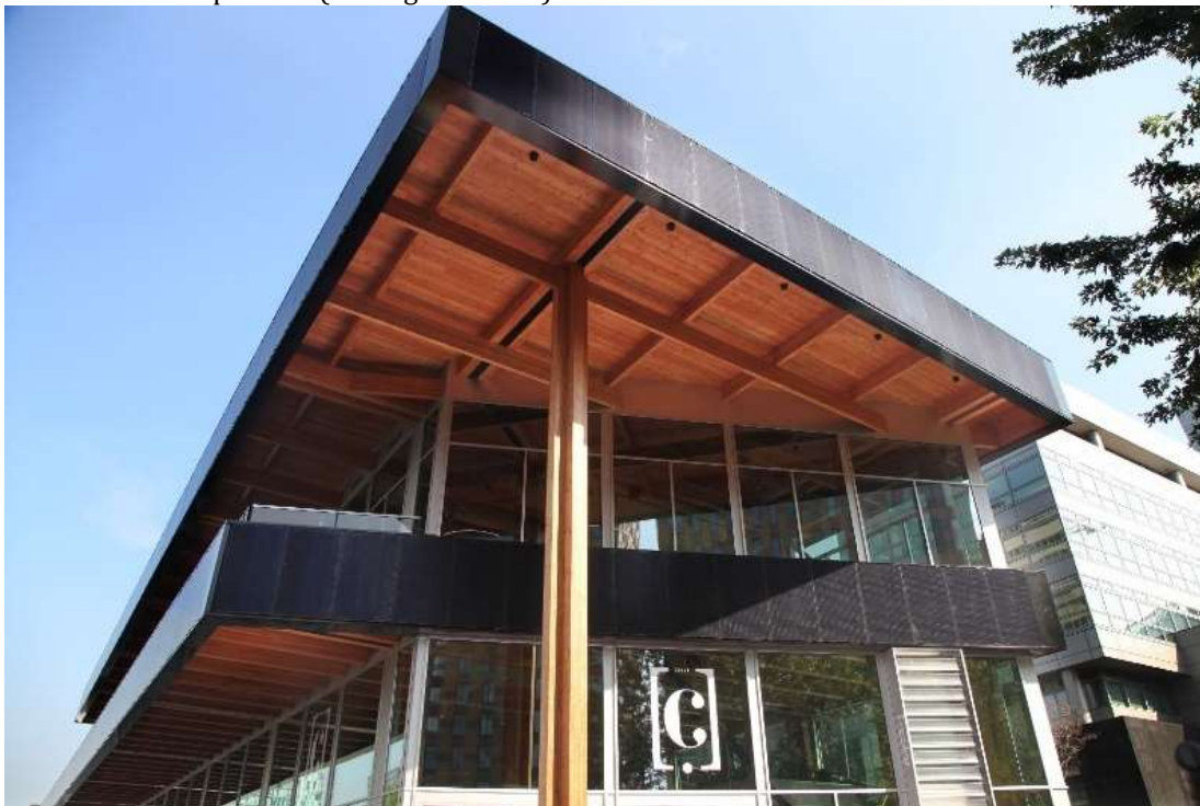
Exasun panelen in het Circl paviljoen
