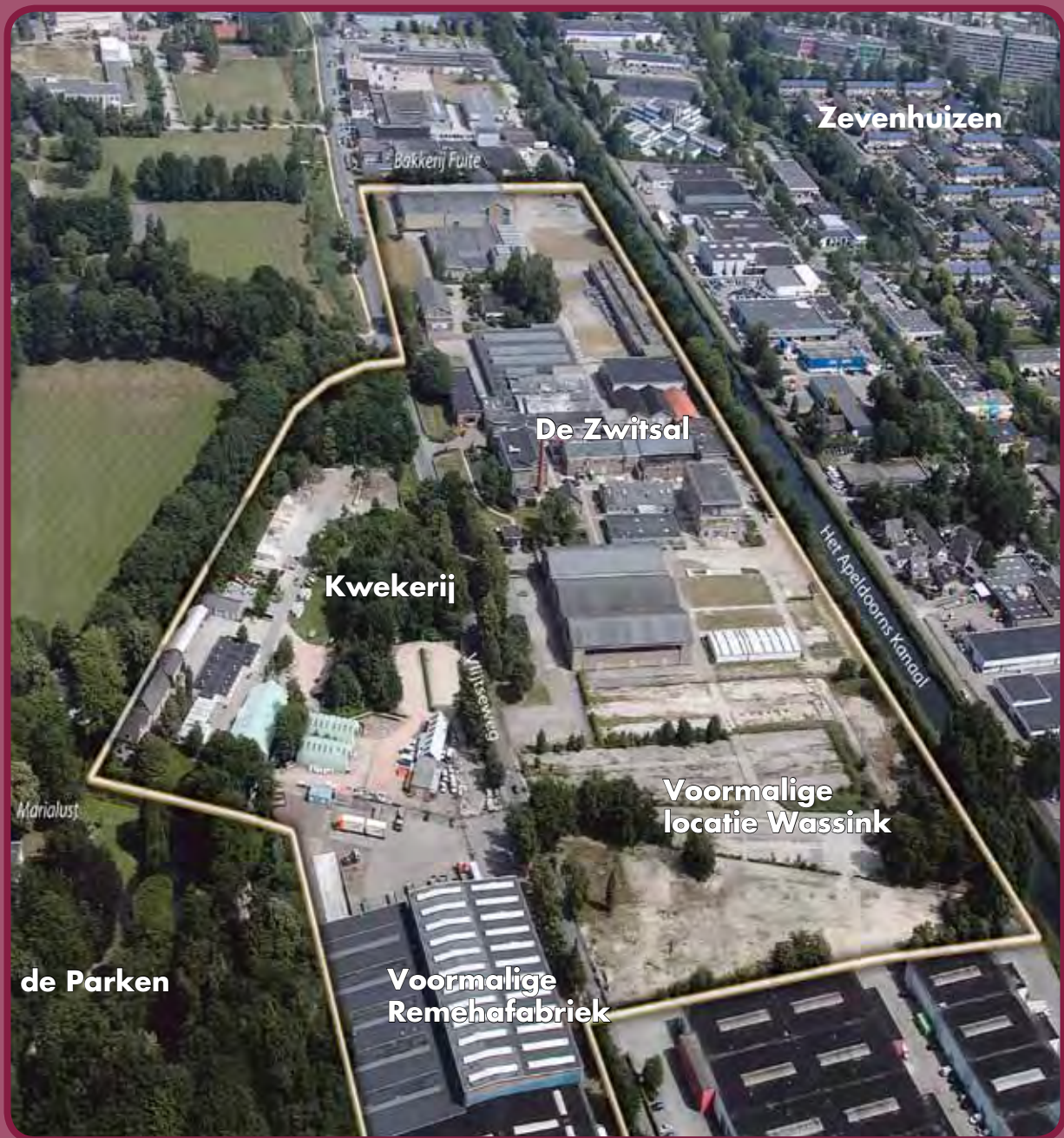
Huidige situatie projectgebied Vlijtsepark. (gezien vanuit het zuiden)
