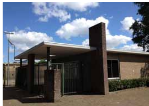
Voormalige portiersloge aan de Vlijtseweg
