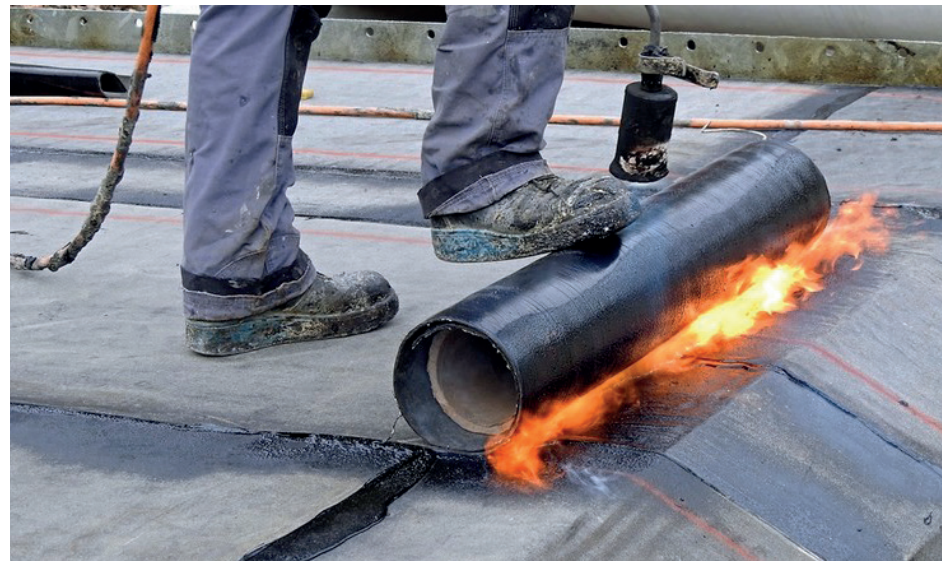
Figuur 78. aanleggen van bitumen
