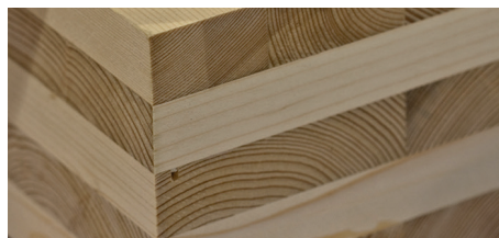
Figuur 36. CLT detail
