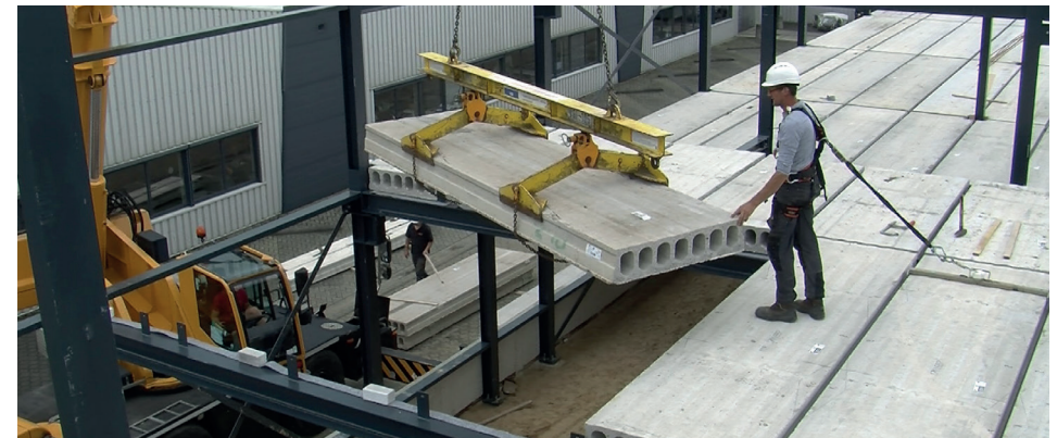
Figuur 49. Montage kanaalplaatvloer
