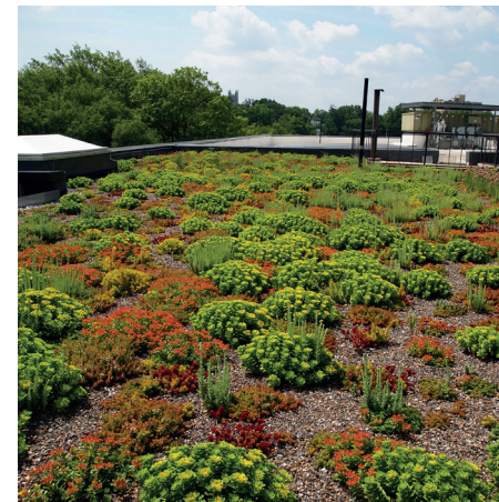
Figuur 76. sedum dak
