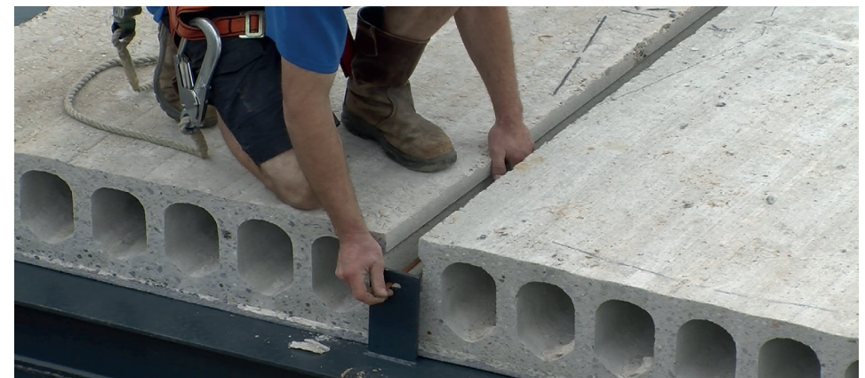
Figuur 50. Montage kanaalplaatvloer
